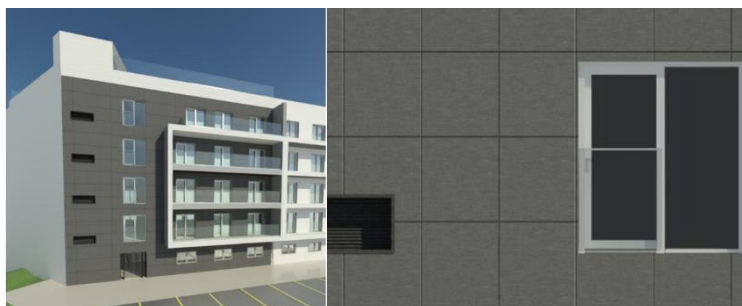
Figura 6.1 – Fachada principal com placas em grés porcelânico cinzento 40x40cm 2 .
